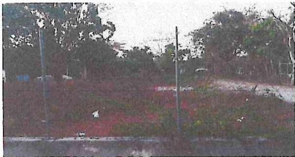
Foto 1: Reparación de muro perimetral parte exterior
