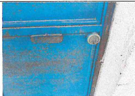
Foto 6: Sustitución de chapa de 2 puertas.
