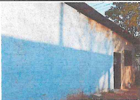
Foto 3: Mantenimiento de pintura parte exterior de pared
