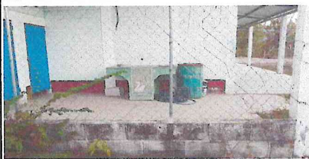
Foto 2: Reparación de tubo hg y malla galvanizada.
