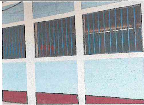
Foto 4: Mantenimiento de pintura parte interior y exterior de 2 aulas
